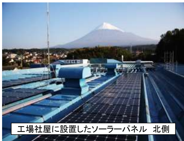
太陽光パネルの設置場所周辺には、遮蔽物がないため、効率よく発電している
